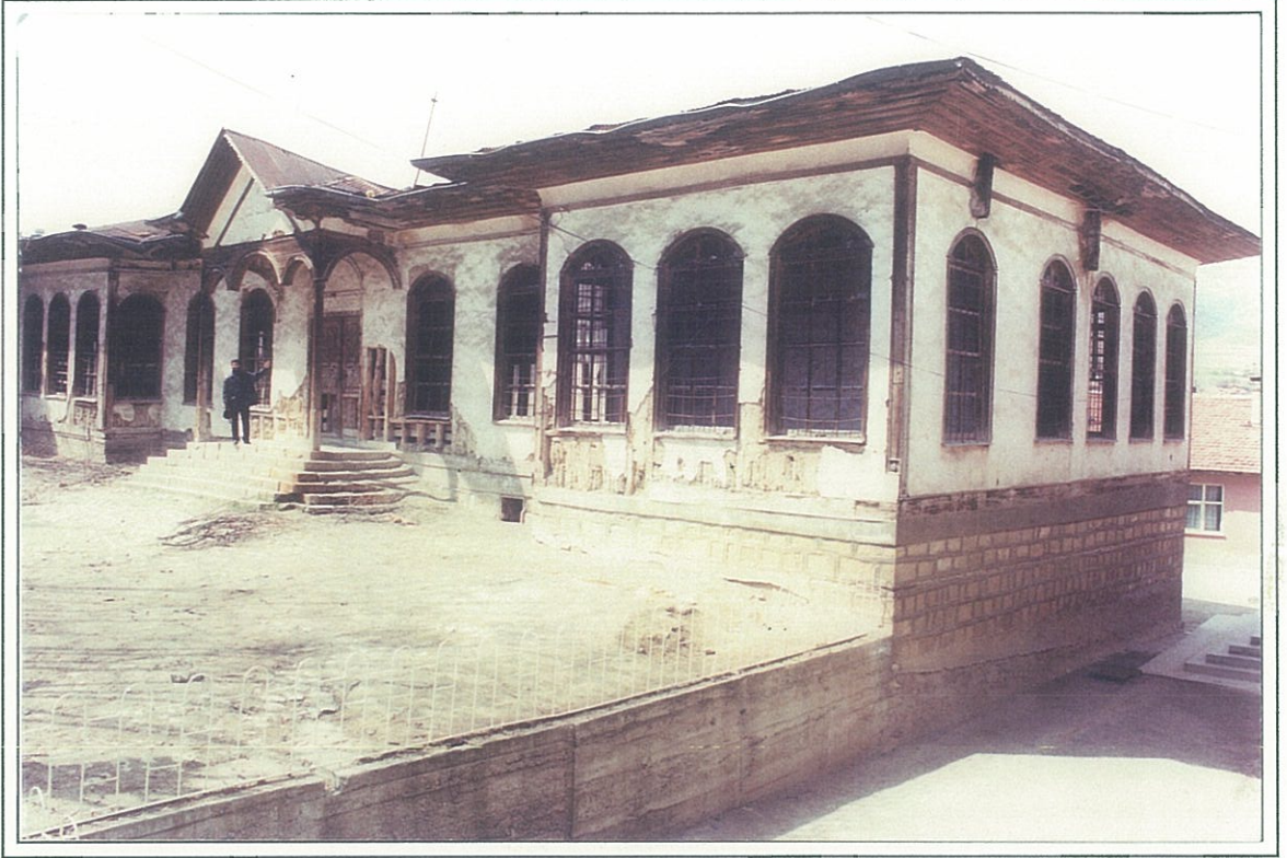
CUMHURİYET İLKOKULU GİRİŞ CEPHESİ GÖRÜNÜMÜ
