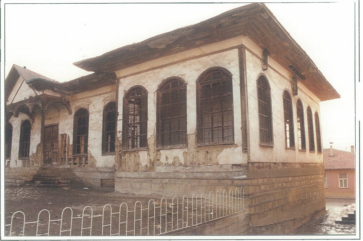
CUMHURİYET İLKOKULU GİRİŞ CEPHESİ DETAY GÖRÜNÜM
